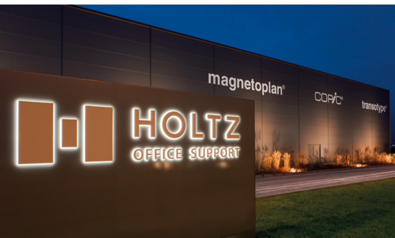
Zeichen gesetzt: der Ende 2010 bezogene Neubau in Wiesbaden
